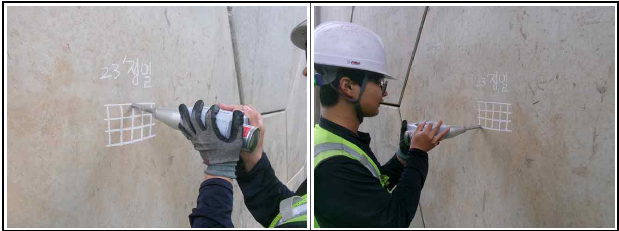
【그림 12.3.6】 슈미트해머를 이용한 반발경도시험 전경
